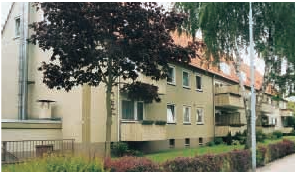
◀ Die Häuser der Neue Lübecker Norddeutsche Baugenossenschaft in der Dockstraße in Lübeck.
